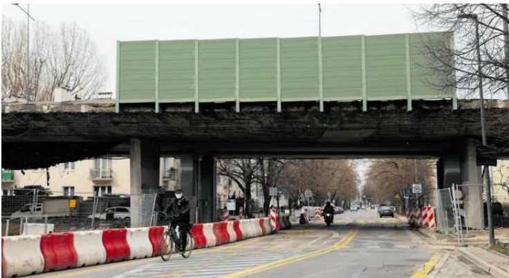
• Rozbiórka wiaduktu nad ulicą Paryską FOT. DAWID ŻUCHOWICZ / AGENCJA WYBORCZA.PL
