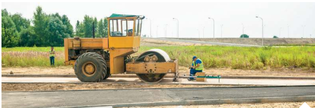
Przy budowie odcinka na S3 w okolicach Polkowic i na obwodnicy Częstochowy w ciągu autostrady A1 doszło do powstania zaległości wobec 71 podmiotów współpracujących z Salini w łącznej wysokości ponad 41 mln zł | fot. Filip Błażejowski/Gazeta Polska
