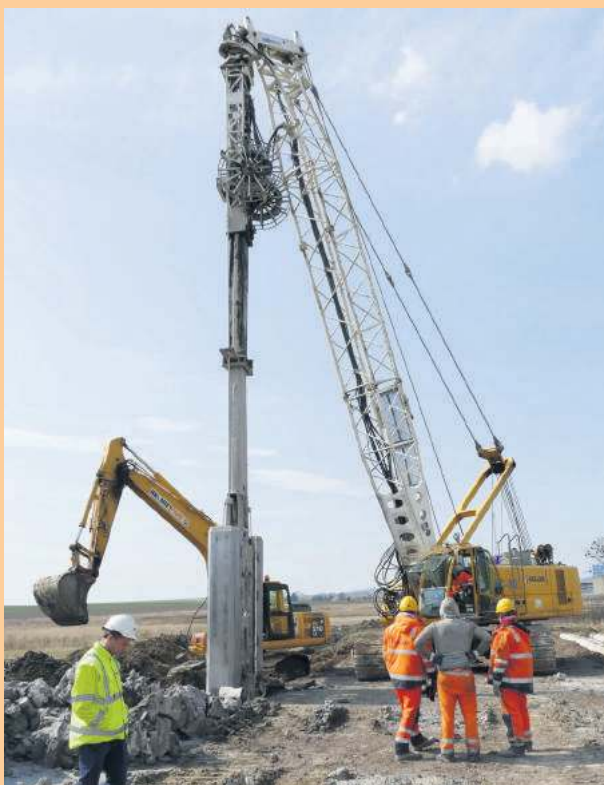
Przysłonę przeciwyfiltracyjną wykonano w dwóch technologiach. Wzdłuż zapory, w czaszy zbiornika, w technologii wąskoprzestrzennej ściany szczelinowej, a przy budowie zrzutowej w technologii iniekcji strumieniowej (Jet Grouting)
