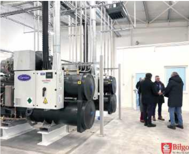
Modernizacja ciepłowni obejmowała montaż pomp ciepła odzyskujących energię z oczyszczonych ścieków oraz budowę instalacji fotowoltaicznej. Zadanie realizowano w formule „zaprojektuj i wybuduj”
