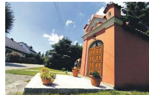
Kaplica przy ul. Morawieckiego w Źródłach
