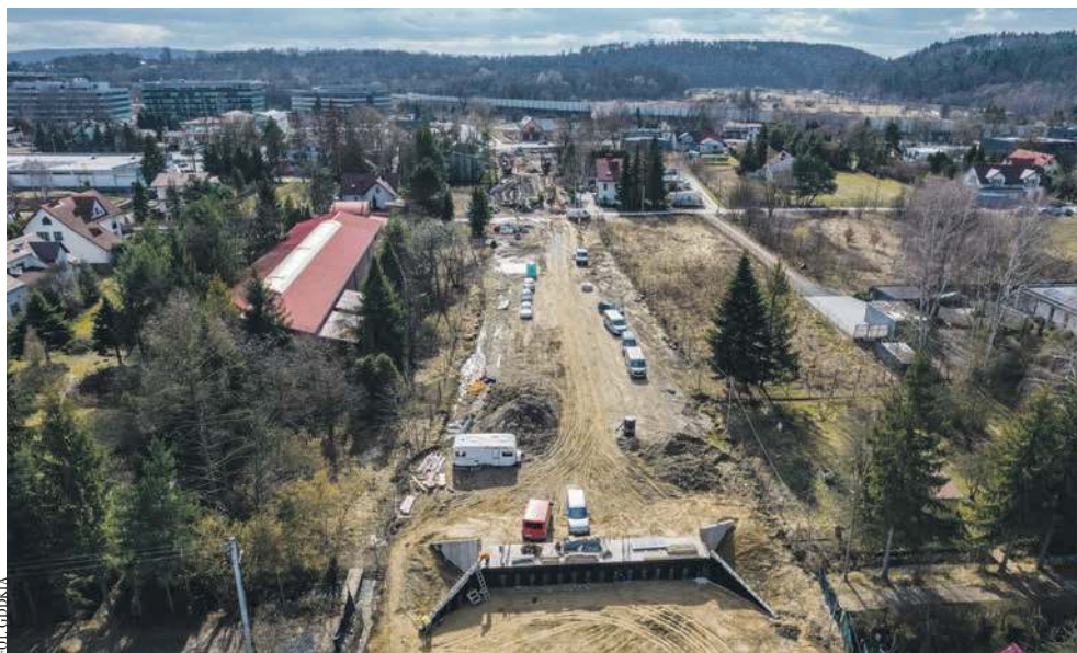
Trwają prace przy budowie obwodnicy Zabierzowa
