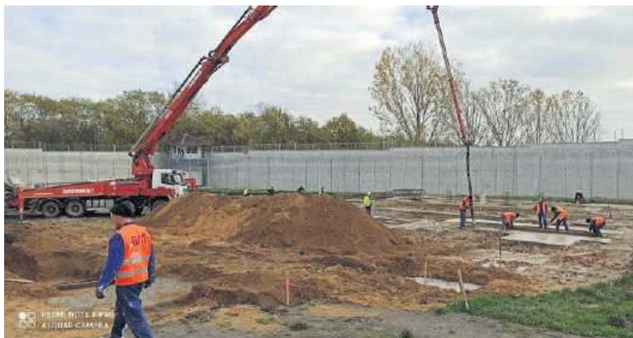
Tak jeszcze niedawno wyglądał plac budowy hali produkcyjnej w strzelińskim więzieniu. Foto: ZK w Strzelinie
