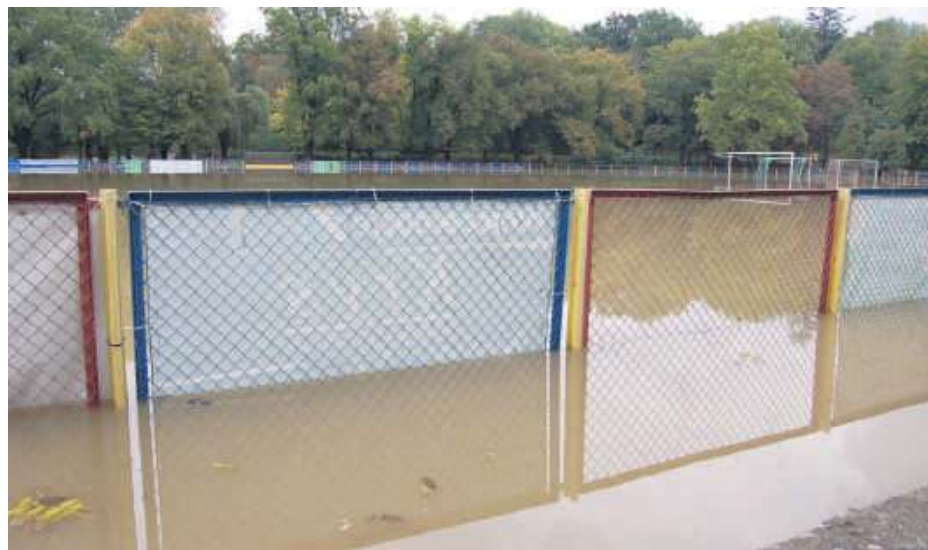
W październiku ubiegłego roku po intensywnych opadach deszczu zalany został stadion miejski w strzelińskim parku. Na zdjęciu zatopiona płyta boiska
