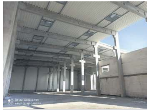
Powierzchnia powstającej hali to ok. 2,2 tys m 2 . Foto: ZK w Strzelinie
