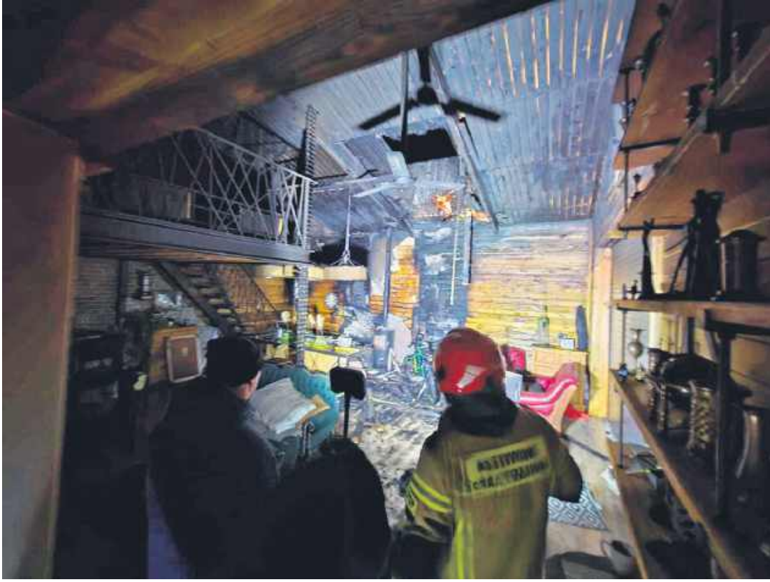
Drewniane wykończenia wnętrza budynku sprzyjały szybkiemu rozprzestrzenieniu się ognia.
