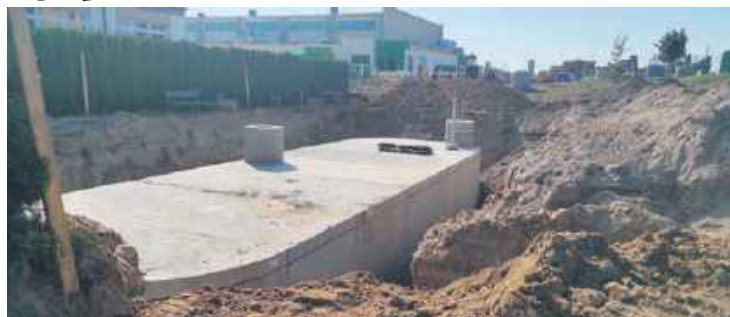
Widok na zbiornik w trakcie realizacji zadania. Fot. UG w Gostycynie
