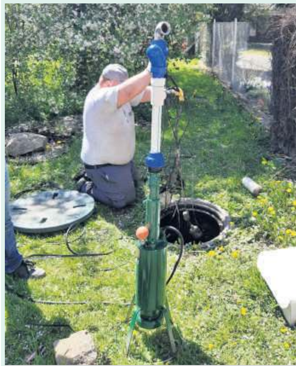
Wymiana pomp rozpoczęła się we wtorek, 11 maja. (Foto: ZUK Kondratowice)
