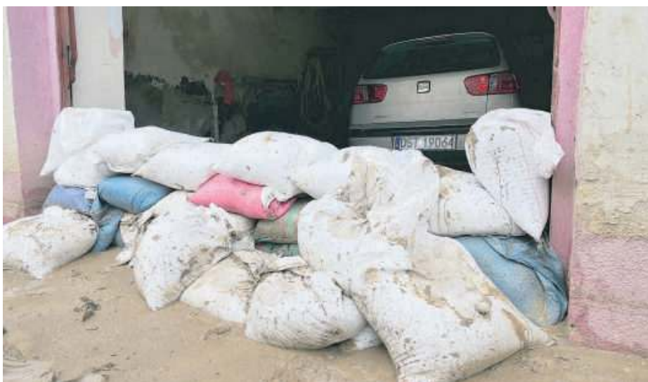
Mimo że strażacy ustawili wał z worków z piaskiem, to nie uchronili garażu przed zalaniem. Na zdjęciu widać ile błota osadziło się przed barykadą
