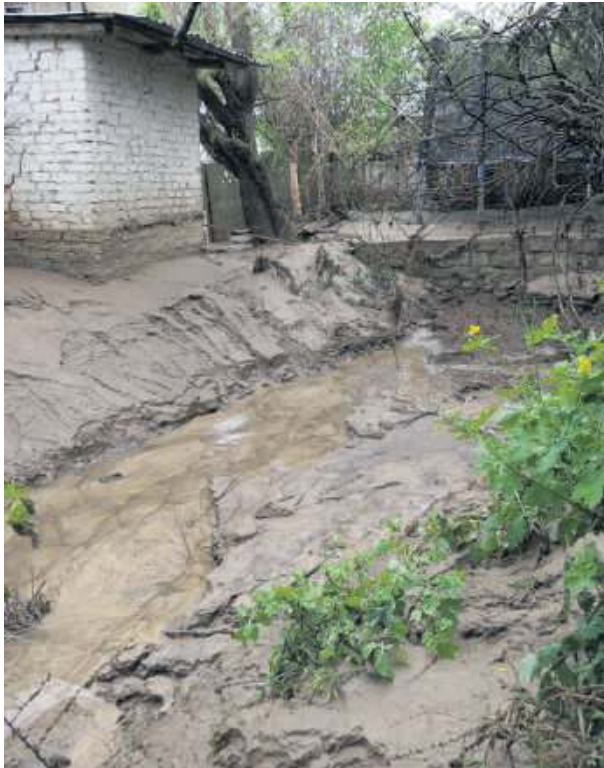
Ten rów był całkowicie niedrożny. Mieszkańcy mówią, że w normalnych okolicznościach jest on metr głębszy. Na budynku widać, dokąd sięgała woda...
