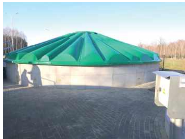
Inwestycja polegała na rozbudowie mechaniczno-biologicznej oczyszczalni ścieków
