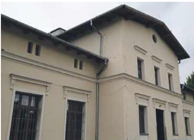
Budynek stacji kolejowej w Skokowej.
