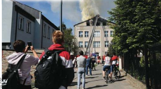
Pożar dachu liceum w Grodzisku Mazowieckim,
