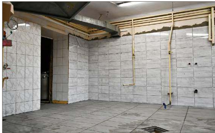
Stołówka w SP nr 2. Są już nowe płytki na ścianach i podłogach.
