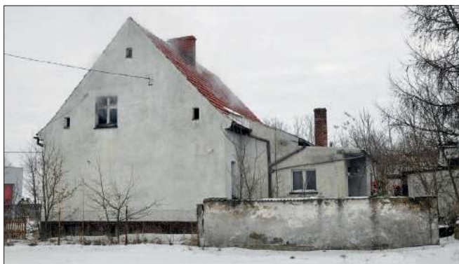
Dom, w którym doszło do pożaru
