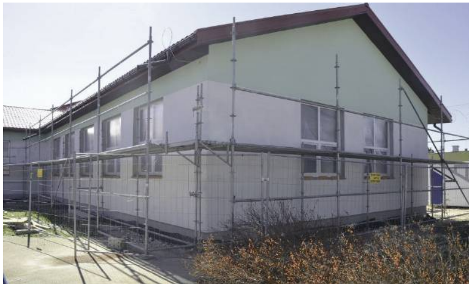
Budynek szkoły w Nowej Wsi w trakcie przebudowy
