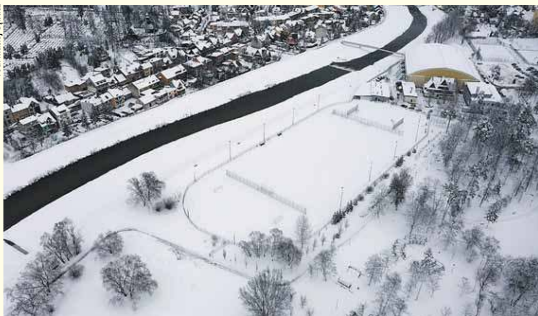
Jedną z szans na całoroczny trening byłoby z pewnością przystąpienie do „Rządowego Programu Budowy Zadaszeń Boisk Piłkarskich”.
