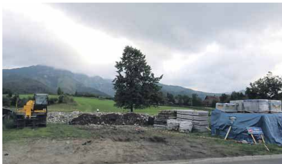
Łąka pod Lipkami zmienia się w kolejny plac budowy.
