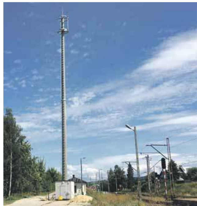
Maszt telekomunikacyjny w obrębie stacji kolejowej w Rabie jest już gotowy.
