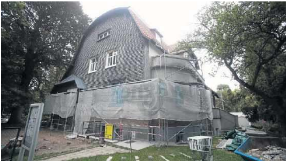
Willi wyróżnia się ciekawą elewacją, która jest częściowo wykończona drewnianym gontem. Obraz dopełnia urozmaicona stolarka okienna (okna łukowe i okrągłe) oraz dworkowe wejście
