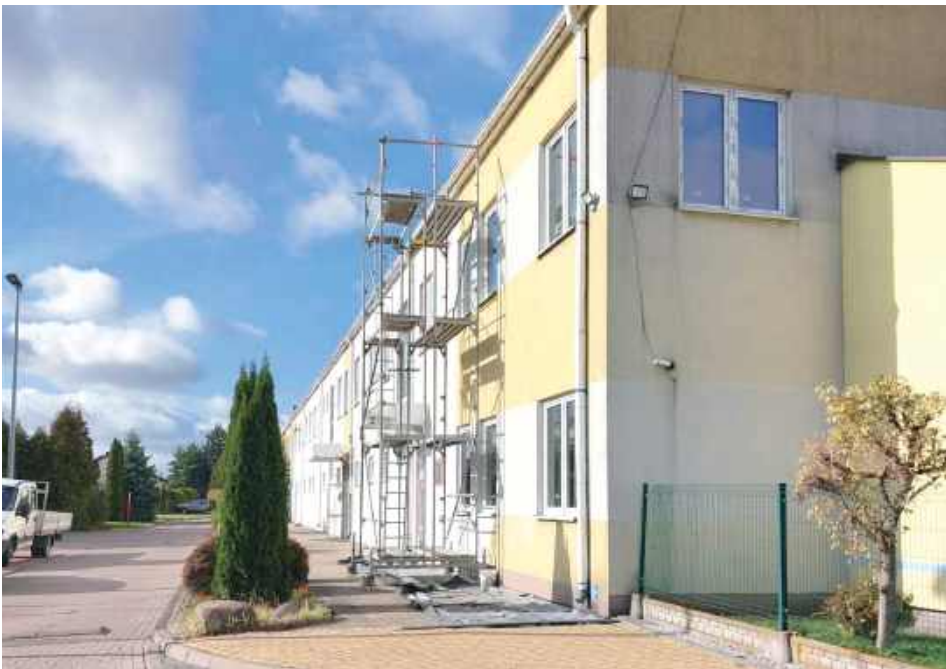
Rozpoczęta w obecnym roku przebudowa hali sportowej wraz z zapleczem przy ulicy Sienkiewicza 27 będzie kontynuowana w 2025 r.
