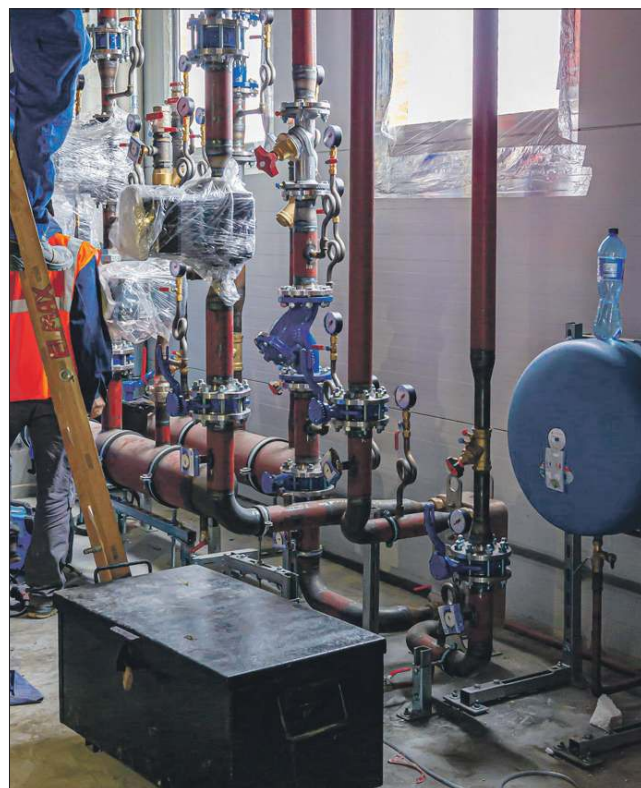
W nawie bocznej lodowiska powstaje kotłownia
