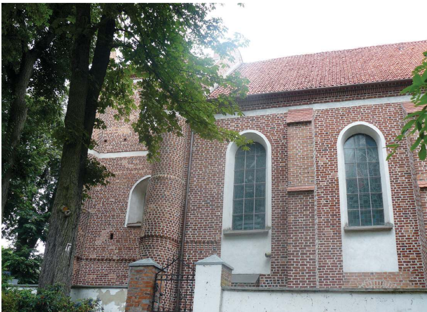
Odnowiona elewacja gotyckiego kościoła z Serocka
