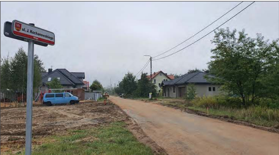
Ulica Kochanowskiego w Wildze jest jednym z kilkunastu odcinków dróg gminnych, które są przebudowywane w ramach I edycji Polskiego Ładu
