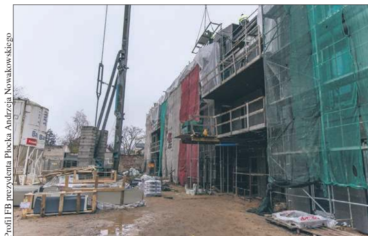
Trwa budowa bloku przy ul. Sienkiewicza 21
