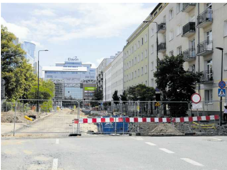
• Budowa linii tramwajowej na ul. Rakowieckiej
