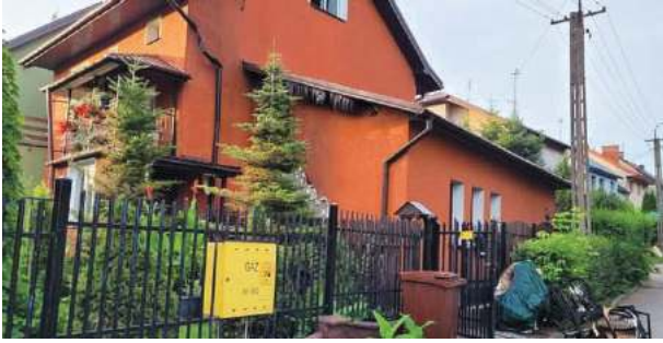
Pożar w domu jednorodzinnym przy ul Sienkiewicza. Zdjęcie z fb OSP w Głodowie
