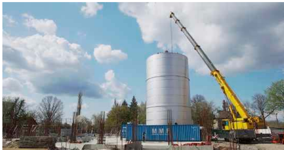
Na placu budowy trwa montaż kolejnych urządzeń
