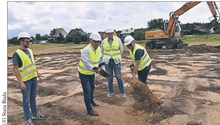
Właśnie rozpoczęły się prace przy budowie żłobka i przedszkola
