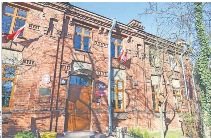
W najstarszej plockiej podstawówce – Szkole Podstawowej nr 6 – trwa renowacja zabytkowej części budynku i remont sali gimnastycznej
