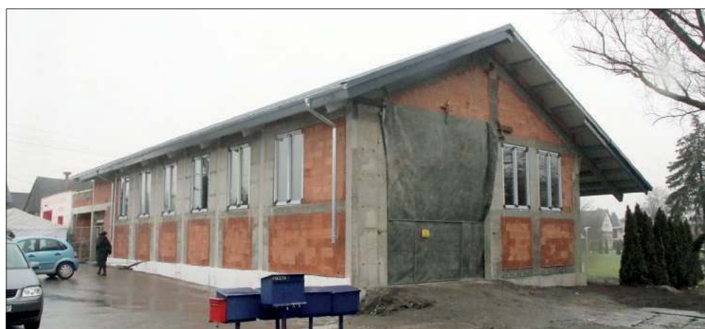
■ Na gruzach starej, niewielkiej hali powstaje obecnie nowy kompleks, który został połączony z lokalną jednostką Ochotniczej Straży Pożarnej
