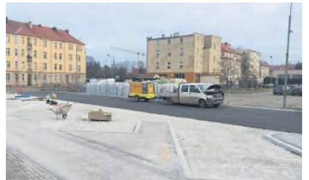
W ramach inwestycji wykonano stanowiska postojowe dla busów Strzeleckiej Komunikacji Publicznej i innych przewoźników
