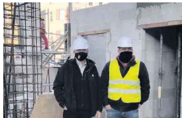
Zdzisław Rataj (po lewej) i Krzysztof Okulicz na tle pierwszego położonego na budowie stropu
