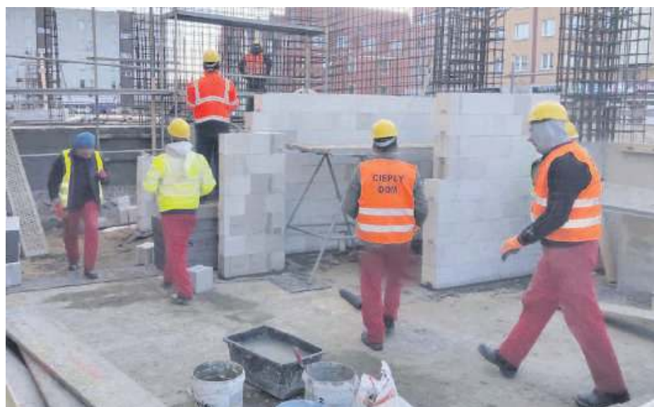
Pogoda sprzyja więc praca na budowie ratusza wre
