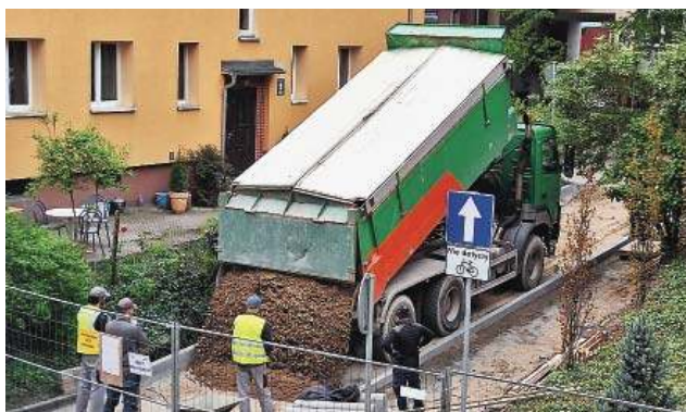
Jeden z projektów w ramach OBO realizowanych na terenie Osiedla Grunwaldzkiego
