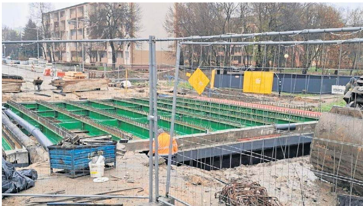
Jest już położona nowa konstrukcja mostu nad Potokiem Północnym na ulicy Chrobrego.
