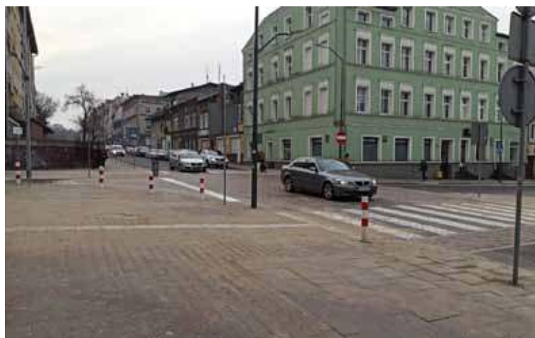
Zakończyła się przebudowa przejścia dla pieszych na skrzyżowaniu ulicy Bolesława Limanowskiego i Wojska Polskiego
