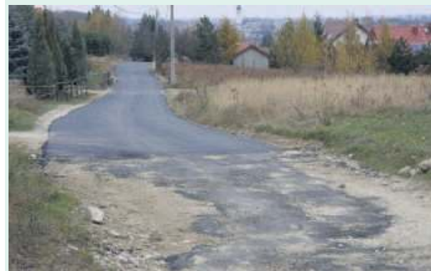
Utwardzenie ulicy Sosnowej w Gęsińcu będzie możliwe, jeżeli uda się zaoszczędzić na oświetleniu drogowym
