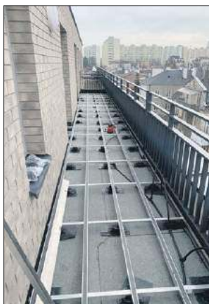
Udoskonalone systemowe legary aluminiowe z dopasowanymi łącznikami zamocujemy z łatwością klocków LEGO
