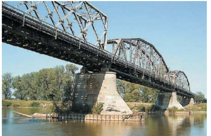
Most kolejowy koło Niska
