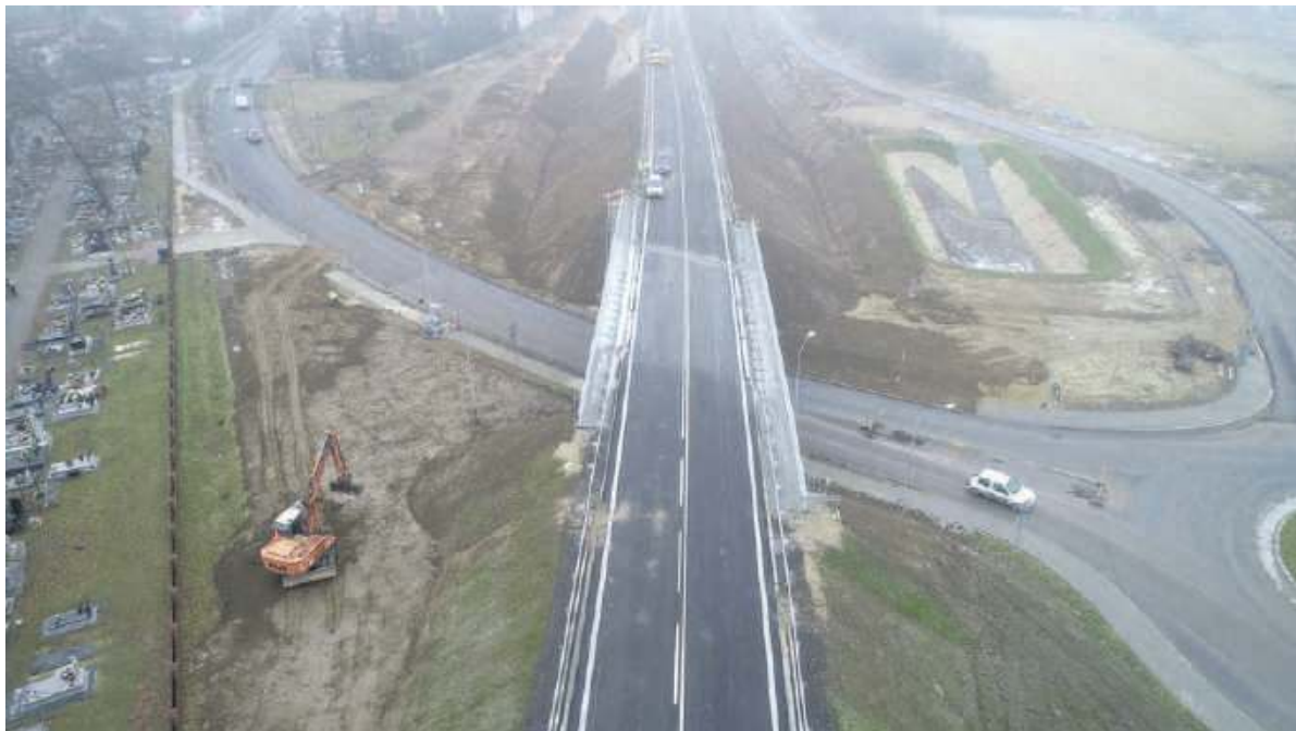
Budowa obwodnicy. Na zdjęciu odcinek w pobliżu cmentarza w Raclawicach
