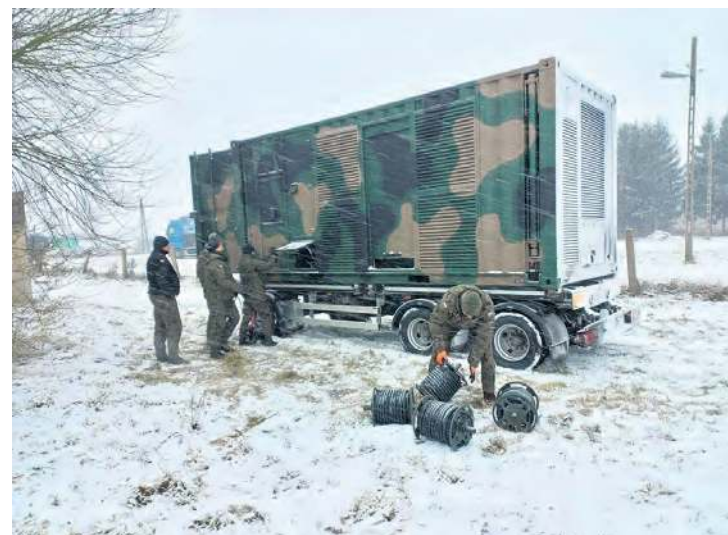
W Bysławiu działała 1/3 zestawu kontenerowej elektrowni KEP-900.
