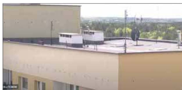
Wkrótce na dachach zostaną zamontowane panele
