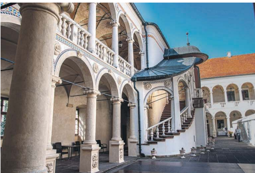
Krużganki od dziedzińca oraz wejście na piętro
