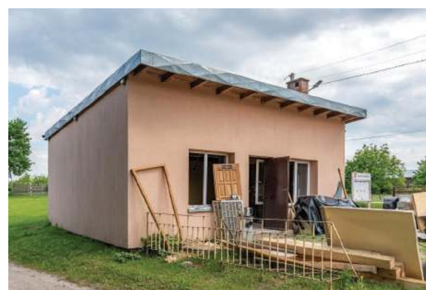
Prace porządkowe już się rozpoczęły
