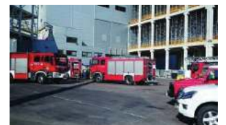
Z uszkodzonej rury wydobywała się niebezpieczna substancja
