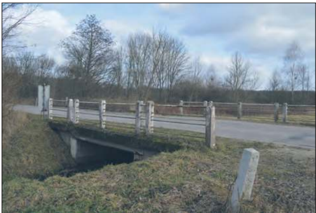
Projekt przewiduje także budowę mostu na rzece Irence w ul. Stawskiej
