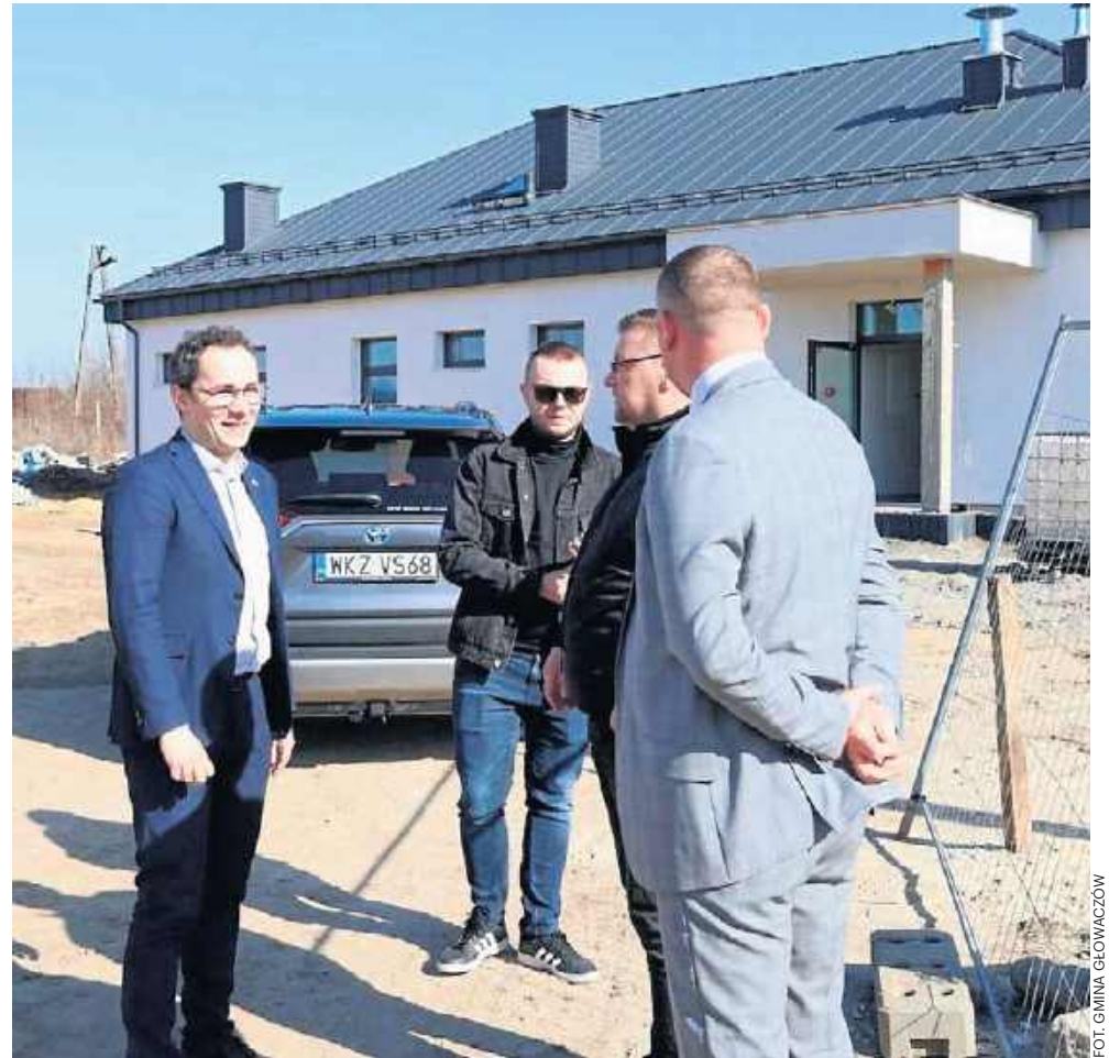
Na placu budowy żłobka w Brzózce.
