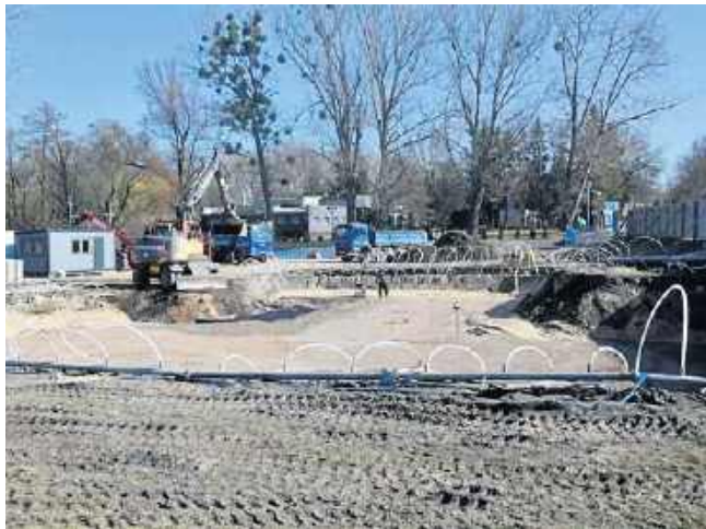
Nad zalewem na Borkach w Radomiu, w miejscu po starym młynie trwa wzmacnianie i osuszanie gruntu.
