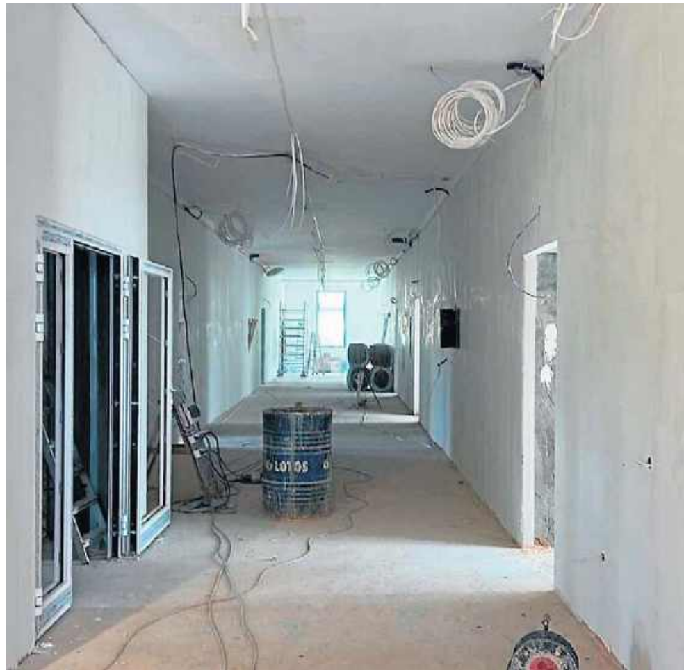
Tak wyglądały prace adaptacyjne dawnego gimnazjum w Jarosławicach na dom pomocy
