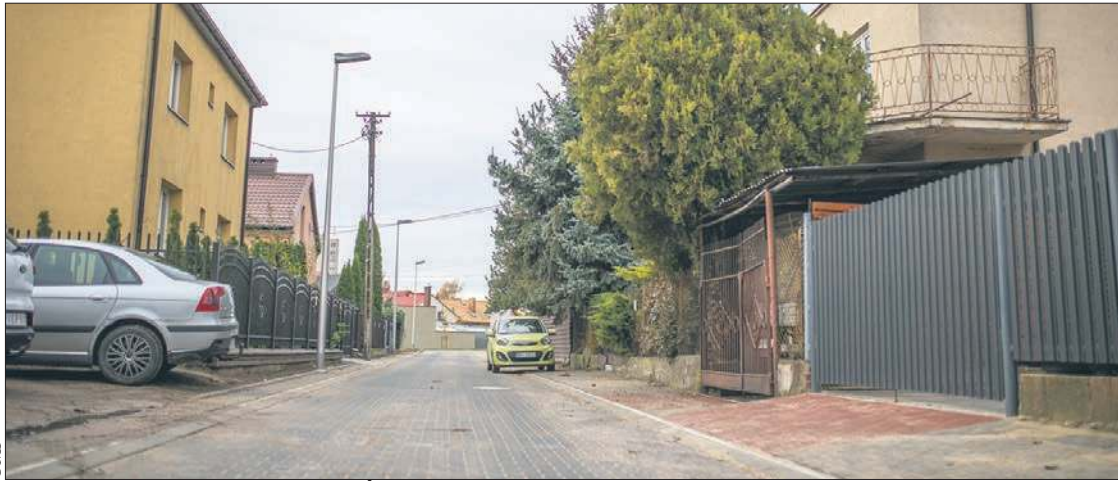
Zakończyła się przebudowa ulicy Żabiej na osiedlu Wyszogrodzka
