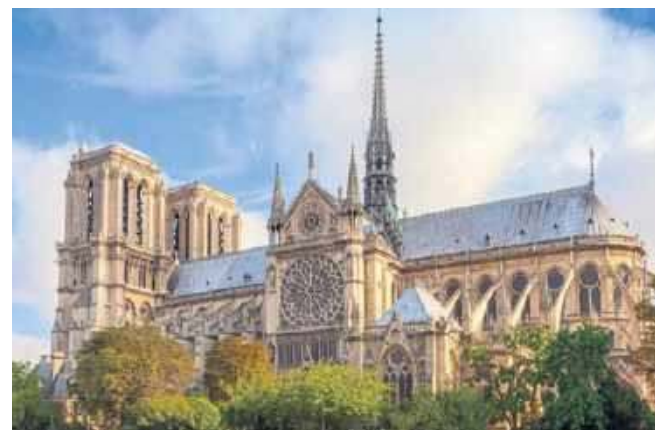
Zapadła już decyzja, że słynna wieżyczka Viollet-Le-Duca, strawiona przez pożar, zostanie odbudowana w pierwotnym kształcie
