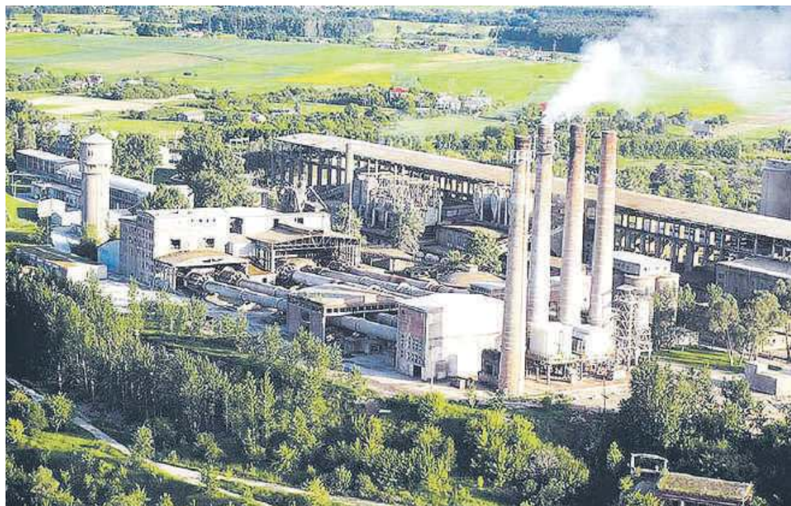
W 2024 roku cementownia w Rejowcu obchodziłaby jubileusz 100-lecia powstania. Do tego czasu nie będzie już po niej śladu
