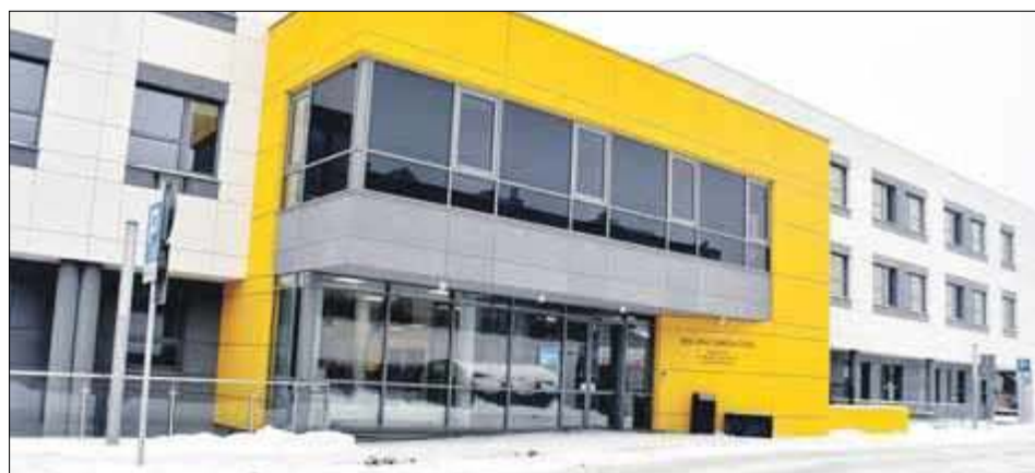
Budowa obiektu trwała dwa lata. Całkowity koszt inwestycji to ponad 63 mln zł
