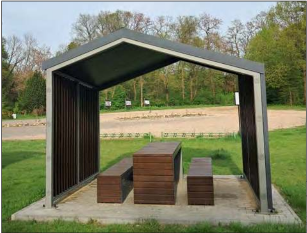
➤ Z racji upływu czasu część infrastruktury uległa naturalnemu zużyciu. Obecnie trwa jej modernizacja. Stare, przeciekające drewniane wiaty zostały zastąpione nowymi, estetycznymi konstrukcjami, które znacząco poprawiają komfort odwiedzających
