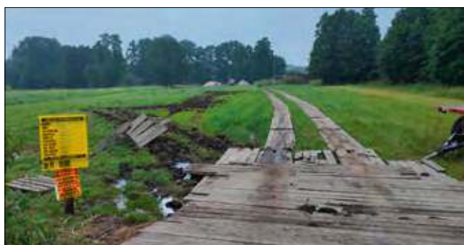
Czytelniczka poinformowała nas o budowie masztu telekomunikacyjnego w pobliżu ul. Myśliwca w Zdzeszowicach.
