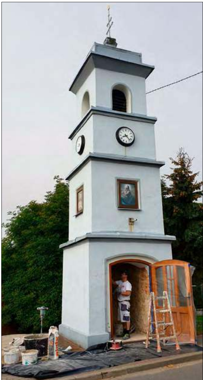
Prace już ruszyły.
