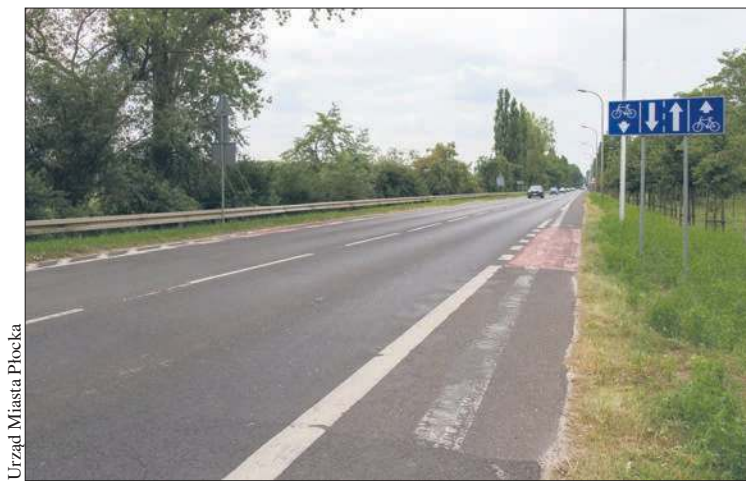
Trwa remont ostatniego fragmentu ul. Kolejowej
