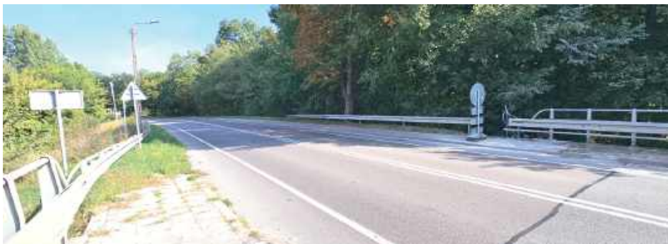
W miejscu, w którym ma przebiegać droga, zaznaczono już drzewa do wycięcia. Nowa droga połączy ul. Lubelską z ul. Kusocińskiego
