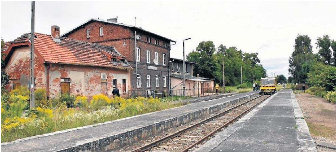
W przyszłym roku odbędzie się rewitalizacja linii nr 256, która obejmie m.in. odbudowę stacji Nowy Staw
